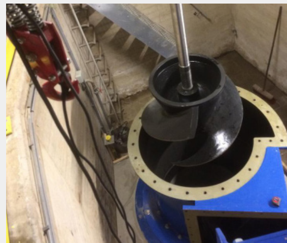
De nieuwe visveilige pomp is in het najaar van 2021 gemonteerd. Tijdens de werkzaamheden bleef het gemaal in bedrijf door een tijdelijke pompinstallatie.
